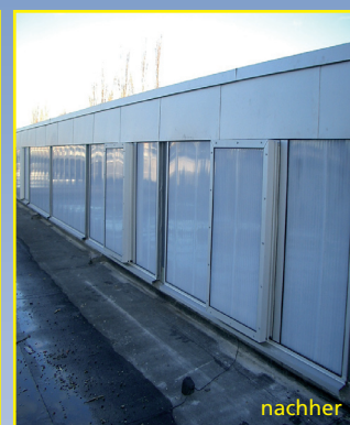
Fassadensanierung mit RWA-Lüftungsklappen.
